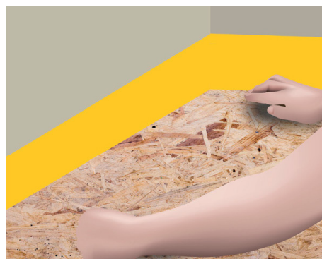
Installatie van de randstrook/ EPS platen snijden
